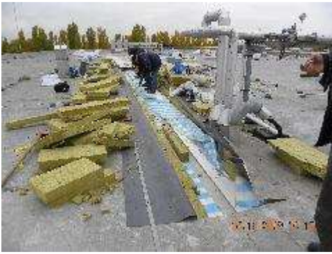
Sanierung tauwasserbelaste BT-Anschlüsse bei Kühllhalle 8000 m 2
