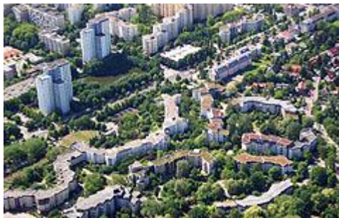
WBB Berlin 1988, 7.000 m 2 - Bundesbaupreis: Pflegefreie Schutzbegrünung bis 35° Neigung, Beratung, baubegleitende Qualitätssicherung
