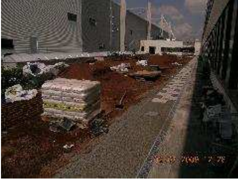
Schenker Fraport Cargo-City: Dachgärten
