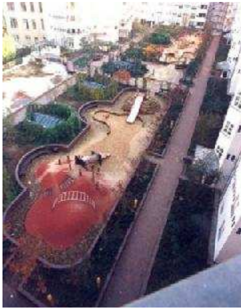
Berlin: Spielplatz über Neubau-Tiefgarage
