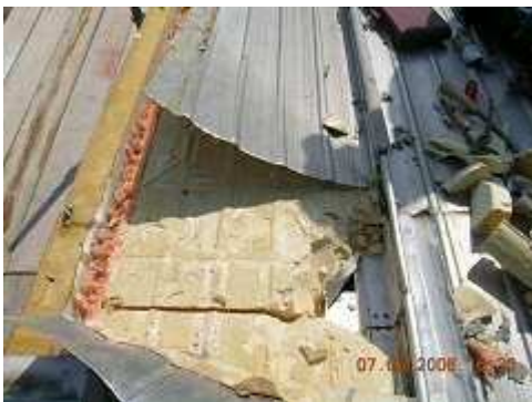
Sandwich-Dachpaneele: Untersuchung auf Luftundichtigkeit und Waermeleckagen
