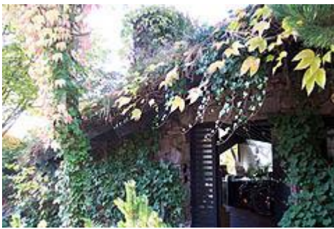
Eingang Passiv-Solarhaus Johannesberg: Naturnahe pflegefreie Steildachbegrünung seit 35 Jahren schadensfrei
