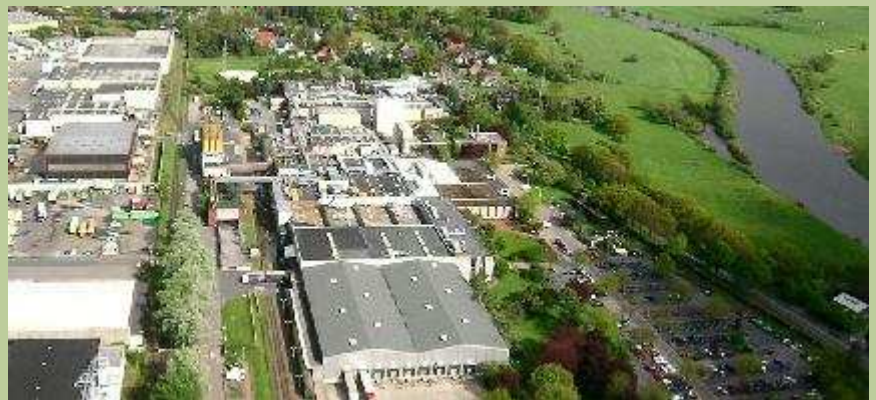
Werkhölge Tiernahrung-Produktion: Genergutachten mit Instandsetzungsprioritäten und Kostenermittlung für Etaplung
