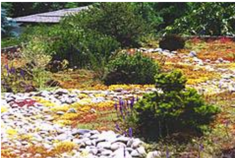
Sanierung einer Tauwasser belasteten Schwimmhalle Seligenstadt: Gestaltete Extensivbegrünung über UK-Dach
