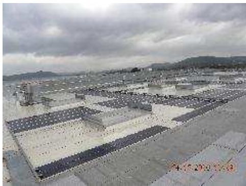
Solarinstallationen bei Cannes (F). Qualitätskontrolle
