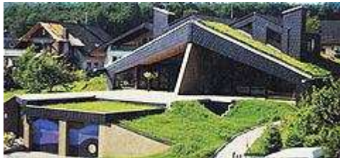
1976 - Das Blumenhügel-Experimentalhaus bei FFM: Passiv-Solarhaus der 1. Generation. Prototyp zur Entwicklung von Flach- und Steildachbegrünungsverfahren (hier noch über Wellzementplatten)
