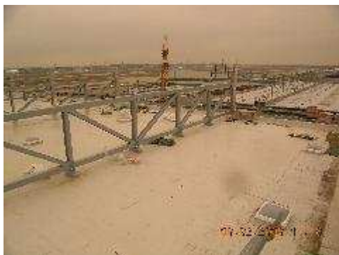
Fraport A380 Cargo Schenker Logistik 14.000 m 2 : MB-Abdichtungen, extensive und intensive Begrünung, Terrassen, Detail-LV-Beratung, baubegleitende Qualitätssicherung
