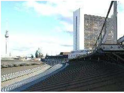
Berlin S-Bhf Friedrichstrasse Mängel- und Instandsetzungsgutachten
