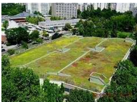
Bei Berlin - 400 m 2 Versuchsdachflächen zur Erprobung kostenoptimierter Langzeit- Schutzbegrünungen und diverser FP□- Dachabdichtungen bei Steil- und Flachdächern
