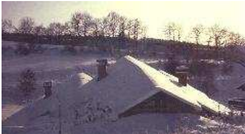
Passiv-Solarhaus Aschaffenburg: Naturnahe Steildachbegrünung seit 36 Jahren schadensfrei
